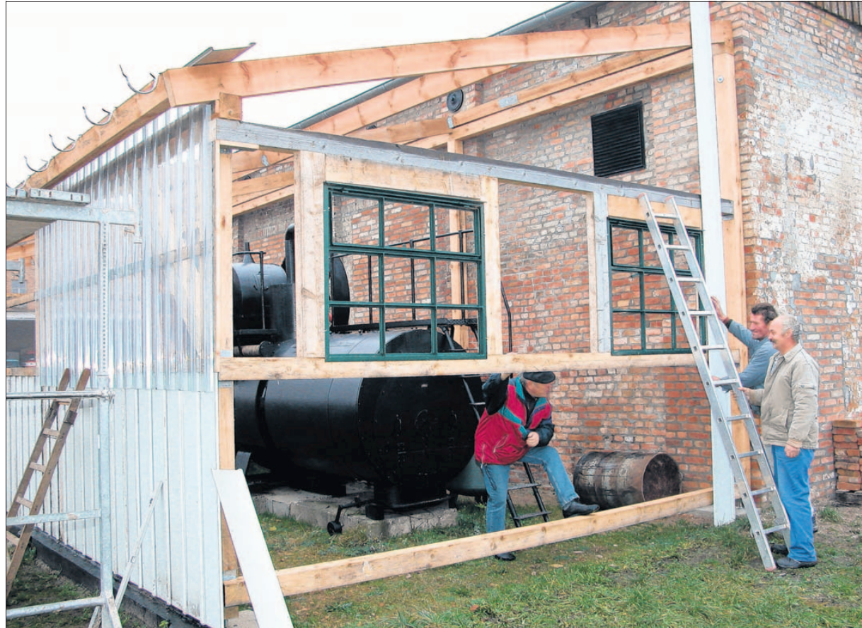
Damit die Maschine sicher und trocken unter Dach und Fach steht, wird fleißig gearbeitet: Auf dem Foto sind Siegmund Goretzki, der Dachdecker Klaus-Dieter Stachowski und Schlosser Werner Brettschneider zu sehen. Foto: V. S.
